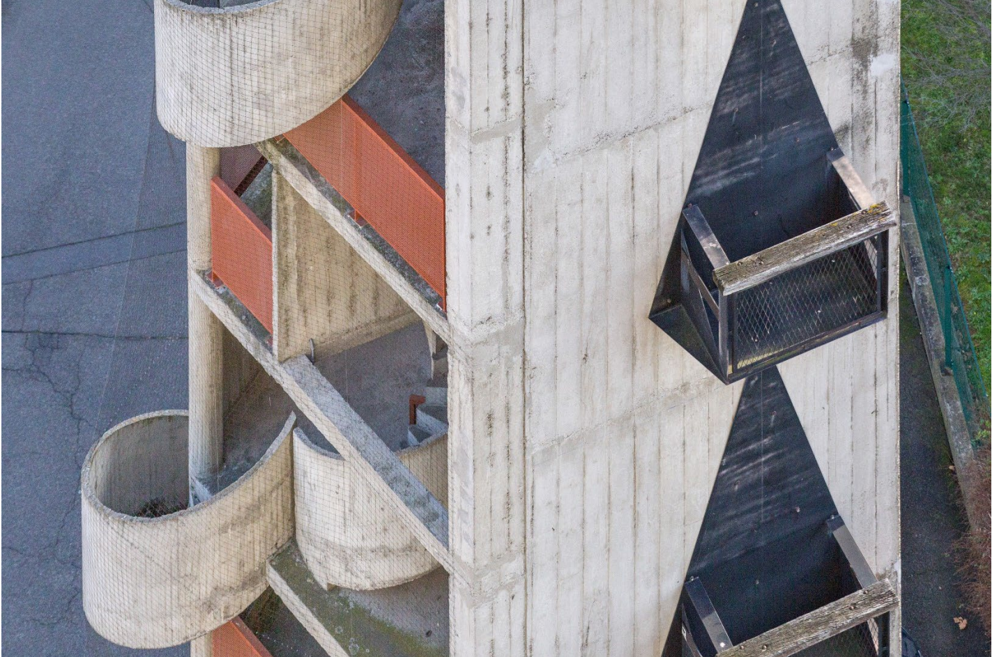
Caserne de pompiers Jacques Vion à Toulouse, 1967-1972 - Vincent Boutin photographe.
